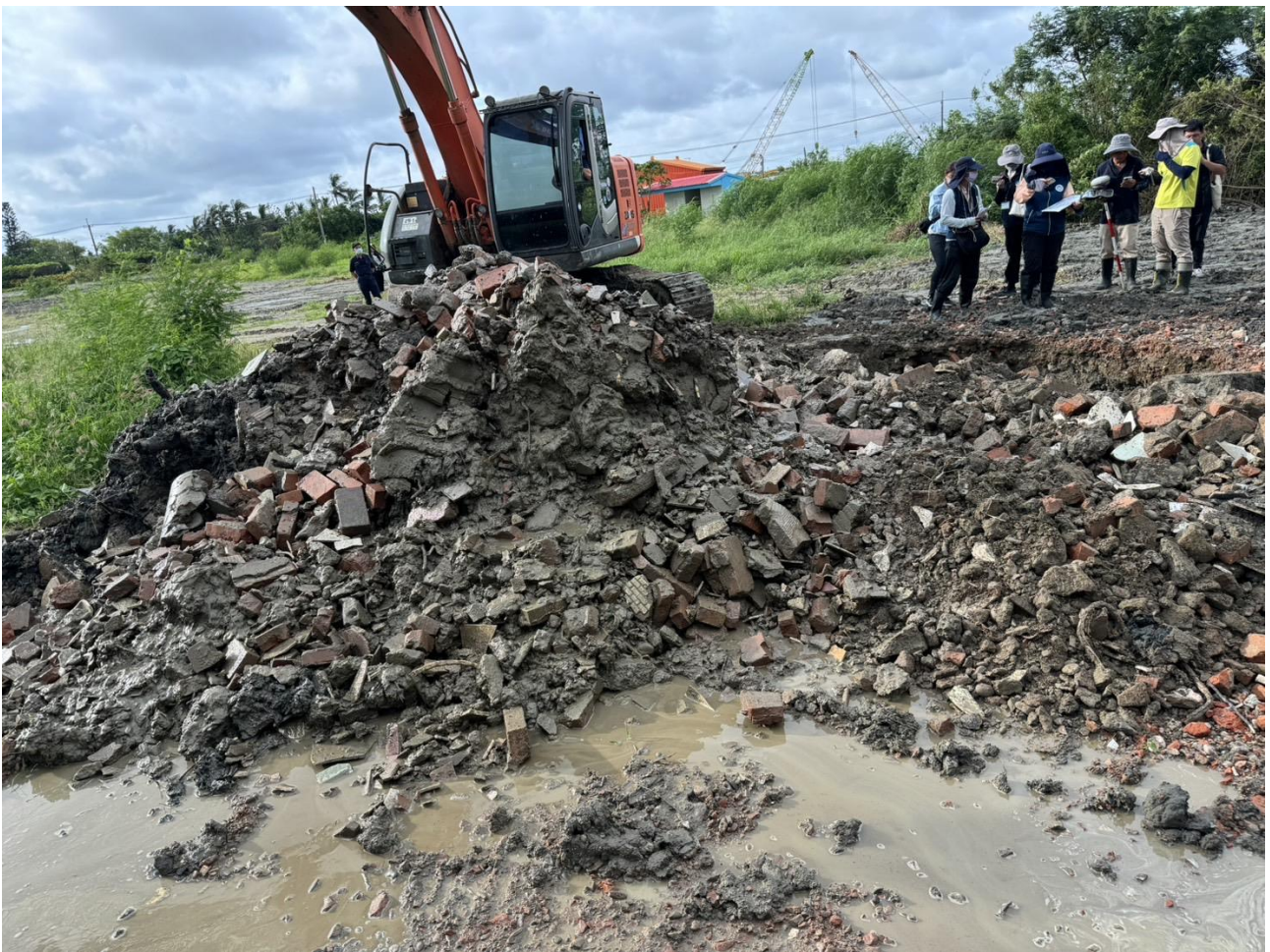
專案小組在現場開挖出回填營建混合物
